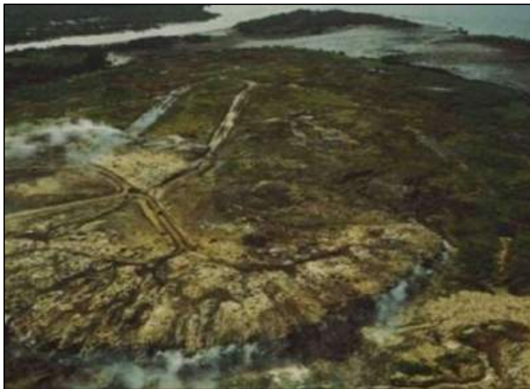
Figura 19 – Foto aérea antes das obras de recuperação, sem data (Fonte: Apresentação “Legado de Gramacho à CTR Rio”, do dia 29/06/2012, na Reunião Ordinária do COMPUR).
