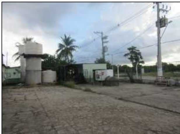
Figura 101 – Vista do depósitos e gerador de energia (21/03/2018).
