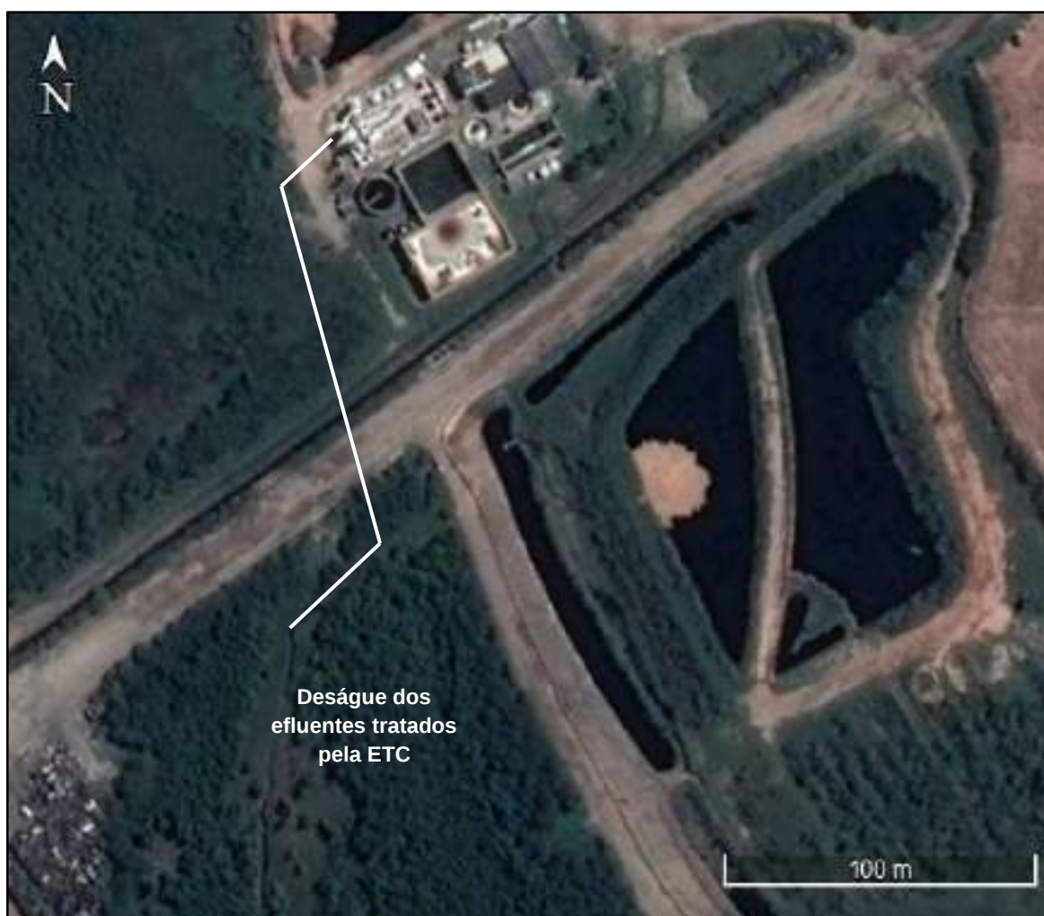
Figura 131 – Vista de satélite dos efluentes tratados pela ETC (Fonte: Modificado de Google Earth, setembro de 2017).
