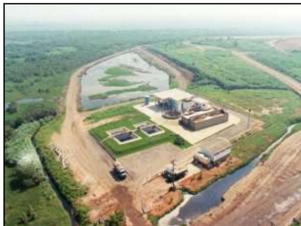
Figura 33 – Central de tratamento de chorume.
