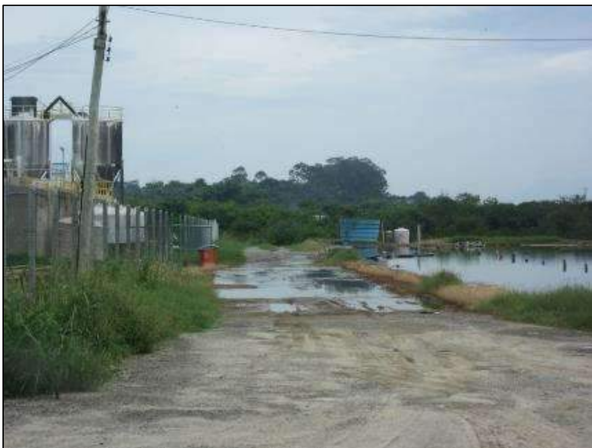
Figura 78 – Chorume verificado na face sul da lagoa de jusante um dia após o extravasamento (22/02/2016).
