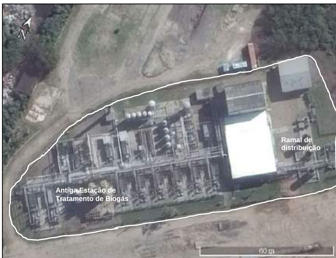
Figura 110 – Vista de satélite da antiga Estação de Tratamento de Biogás (Fonte: Modificado de Google Earth, setembro de 2017).
