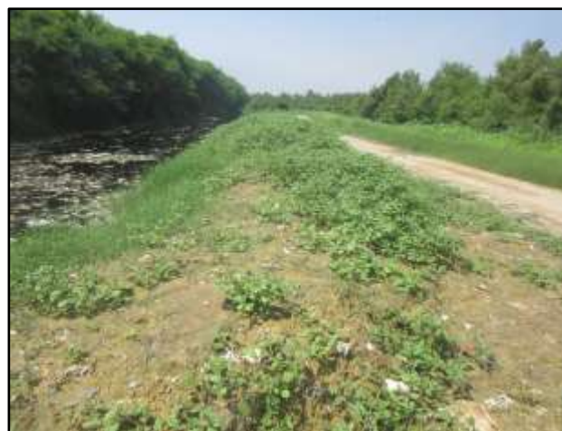
Figura 147 – Detalhe do dique da Vala Sul 4 (14/03/2018).
