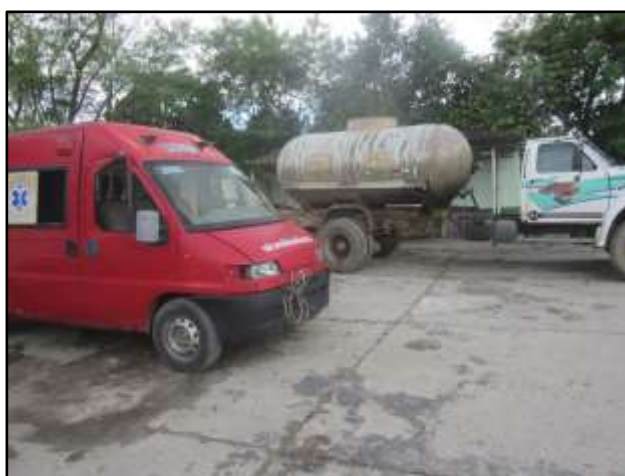
Figura 105 – Estacionamento, com presença de manchas no pavimento (21/03/2018).
