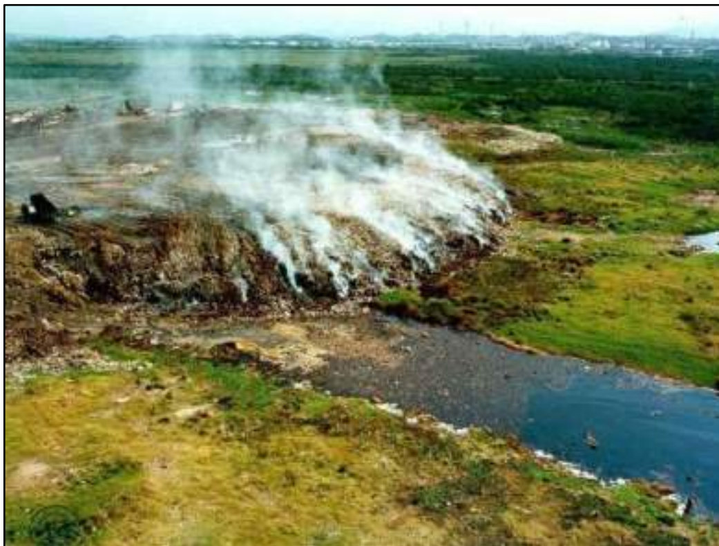
Figura 21 – Foto aérea antes das obras de recuperação, sem data (Fonte: Apresentação “Destinação final e tratamento do lixo urbano na cidade do Rio de Janeiro”, de José Henrique Penido Monteiro).
