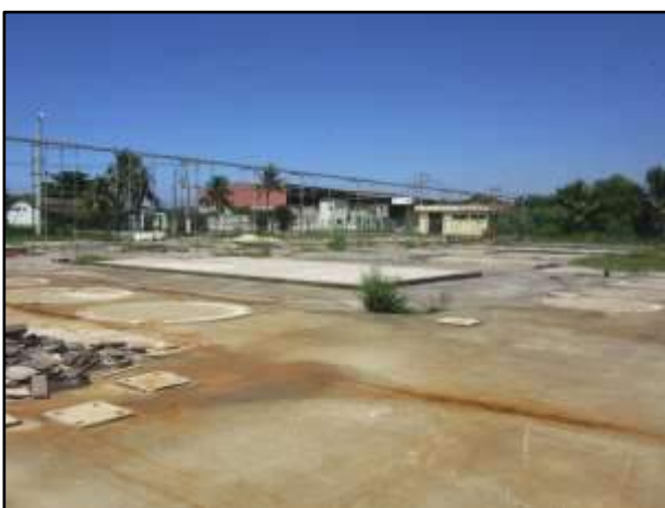
Figura 113 – Vista no sentido NE-SO do local da antiga planta de biogás (26/03/2018).
