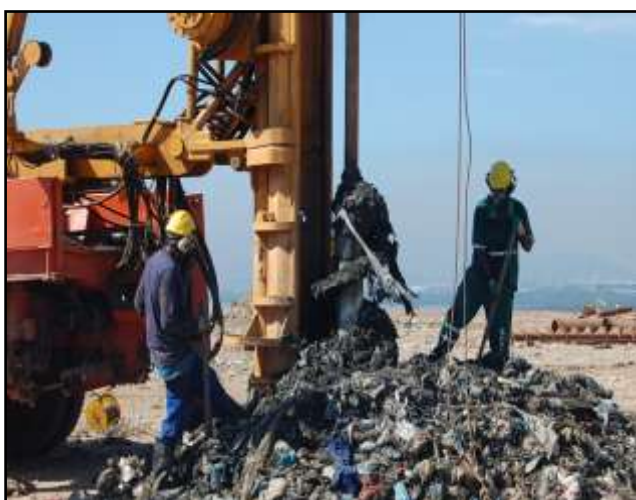
Figura 40 – Perfuração de poços para exploração do Biogás, datada de 2009 (1).
