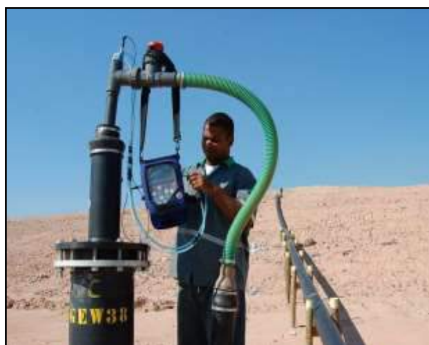
Figura 41 – Perfuração de poços para exploração do Biogás, datada de 2009 (2).
