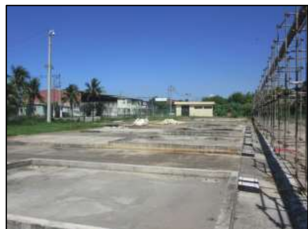
Figura 114 – Vista no sentido leste-oeste do local da antiga planta de biogás (26/03/2018).
