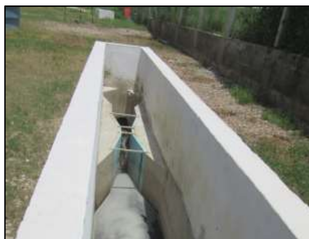
Figura 130 – Calha Parshall (21/02/2018).
