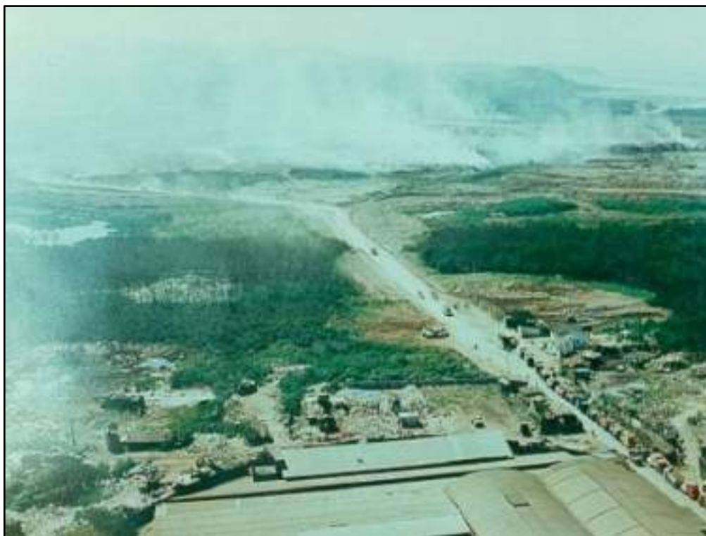
Figura 22 – Foto aérea antes das obras de recuperação, sem data (Fonte: Apresentação “Destinação final e tratamento do lixo urbano na cidade do Rio de Janeiro”, de José Henrique Penido Monteiro).
