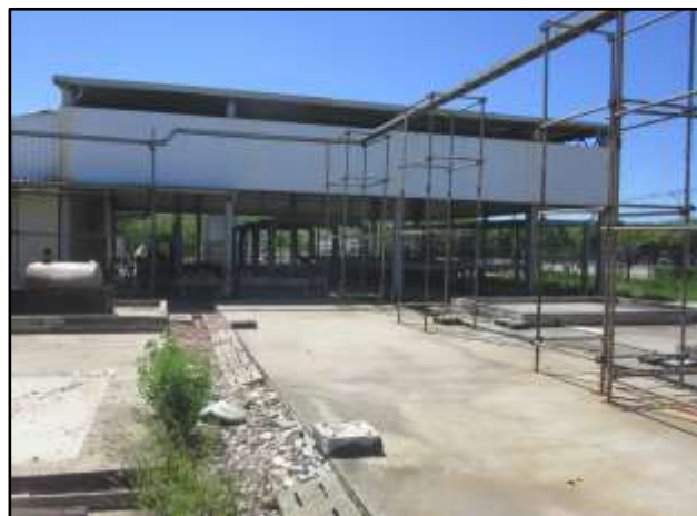
Figura 112 – Vista no sentido oeste-leste do local da antiga planta de biogás (26/03/2018).
