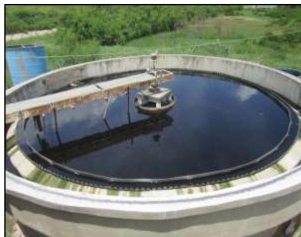
Figura 128 – Decantador secundário (21/02/2018).
