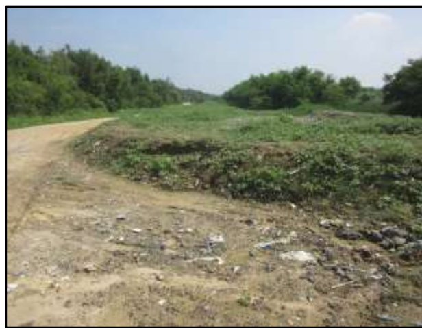
Figura 143 – Detalhe do dique da Vala Sul 3 (14/03/2018).
