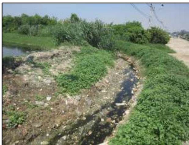
Figura 136 – Vista no sentido NO-SE da Vala Sul 1 (14/03/2018).
