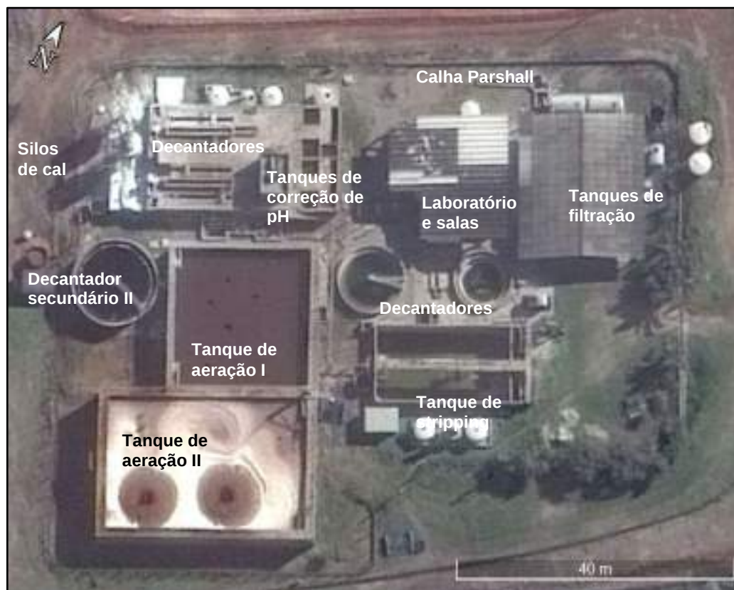
Figura 124 – Vista de satélite da Estação de Tratamento de Chorume (Fonte: Modificado de Google Earth, setembro de 2017).
