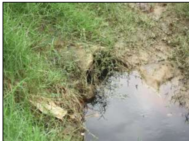
Figura 133 – Detalhe do deságue dos efluentes tratados pela ETC (Agosto/2017).
