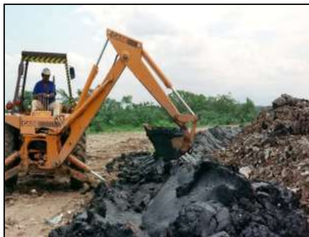
Figura 31 – Construção de dique de contenção ao redor do aterro, feito com argila orgânica de baixa permeabilidade.
