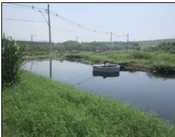
Figura 138 – Vista da Vala Sul 2, próximo à ETC (14/03/2018).
