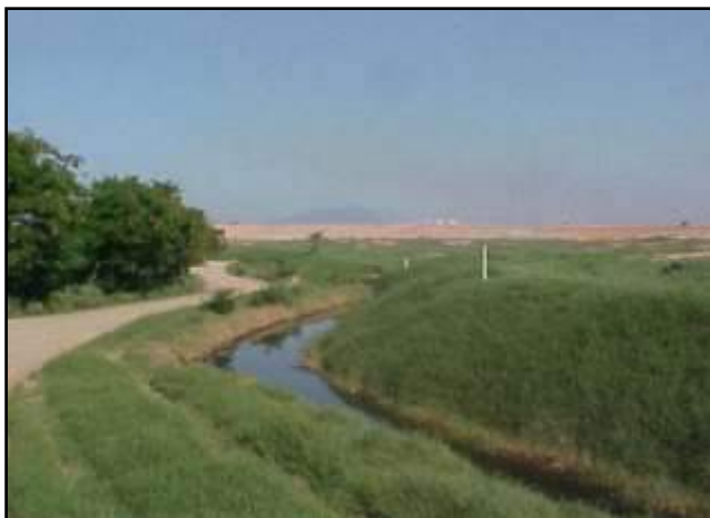
Figura 32 – Sistema de drenagem de chorume.
