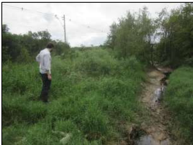
Figura 132 – Vista geral do deságue dos efluentes tratados pela ETC (Agosto/2017).
