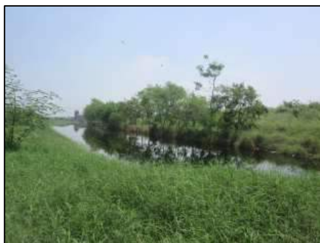
Figura 141 – Vista no sentido SE-NO da Vala Sul 2 (14/03/2018).
