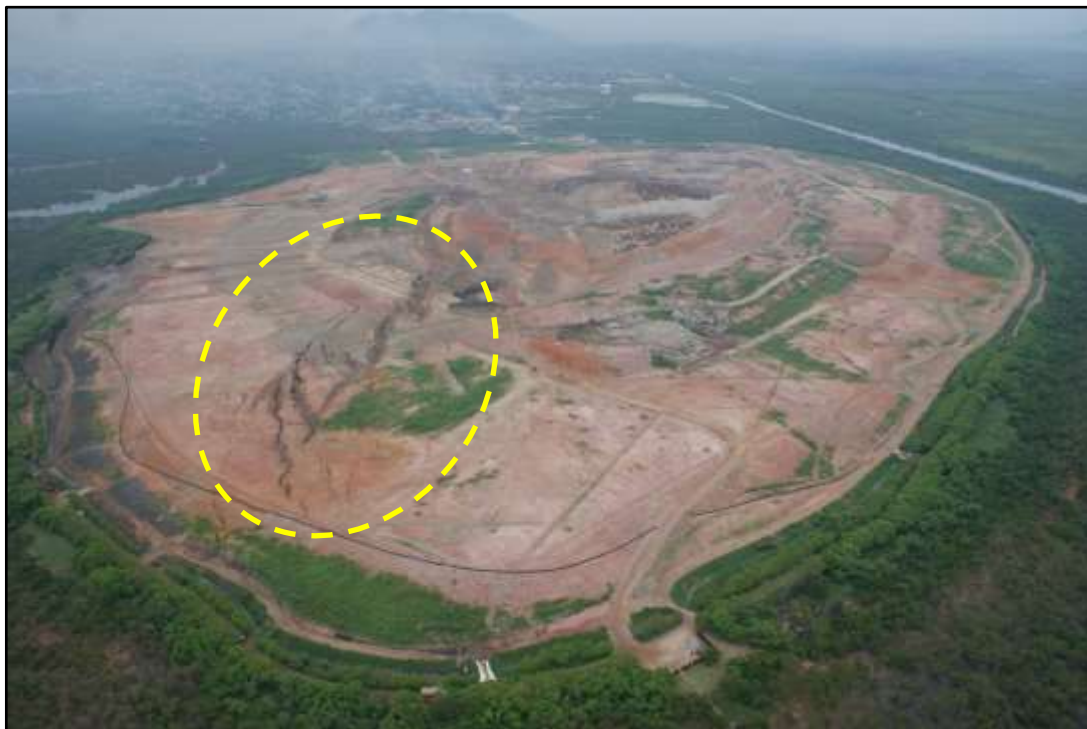
Figura 75 – Ruptura no AMJG, datada de 2010.
