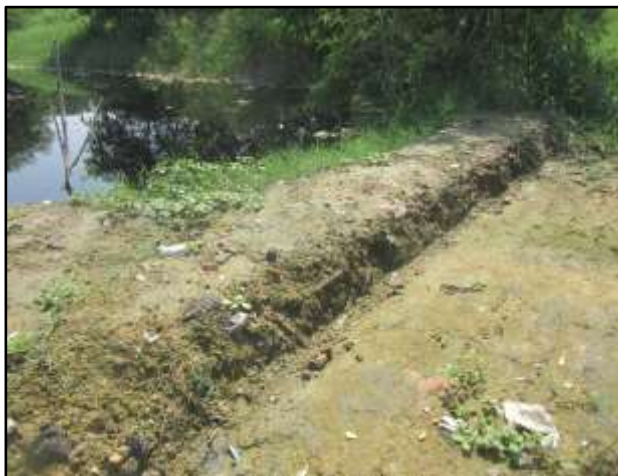
Figura 144 – Detalhe do dique da Vala Sul 3, próximo à Vala Sul 4 (14/03/2018).
