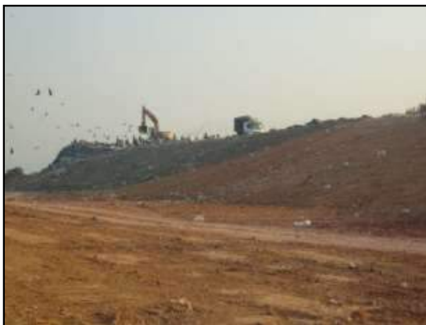
Figura 28 – Praça de operação com cobertura primária e final.
