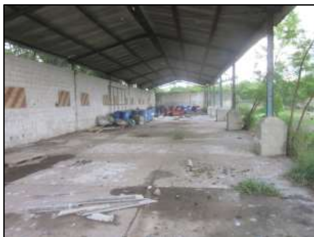
Figura 118 – Vista geral do galpão mais ao norte, no limite do terreno (21/03/2018).
