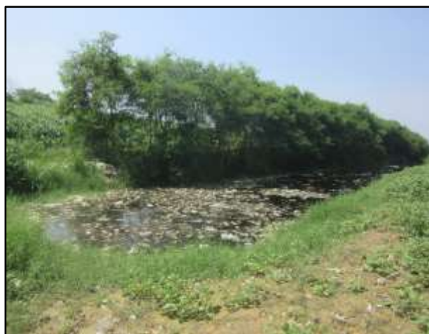
Figura 146 – Vista no sentido norte-sul da Vala Sul 4 (14/03/2018).
