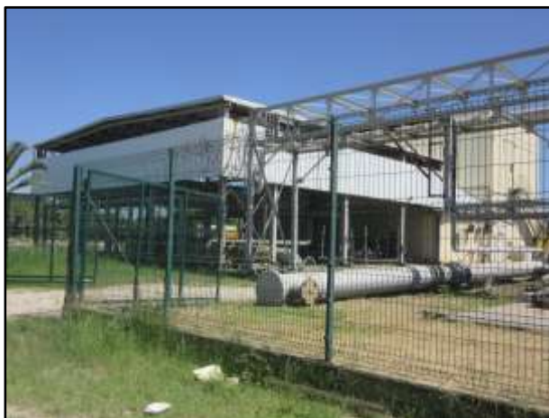
Figura 111 – Vista geral do ramal de distribuição (26/03/2018).
