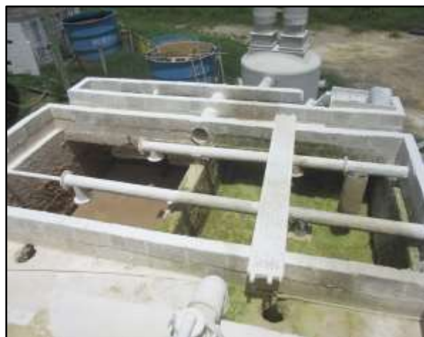
Figura 126 – Coagulação química com adição de cal (21/02/2018).
