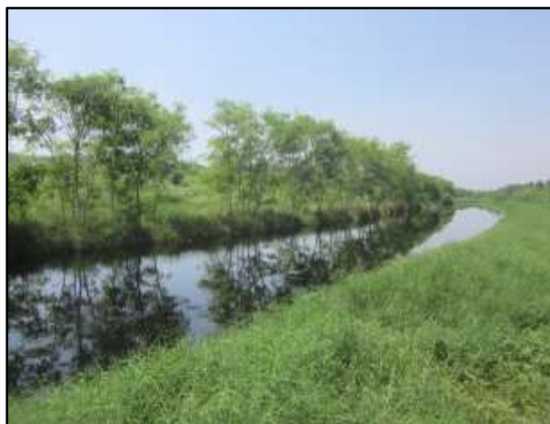
Figura 139 – Vista no sentido NO-SE da Vala Sul 2 (14/03/2018).
